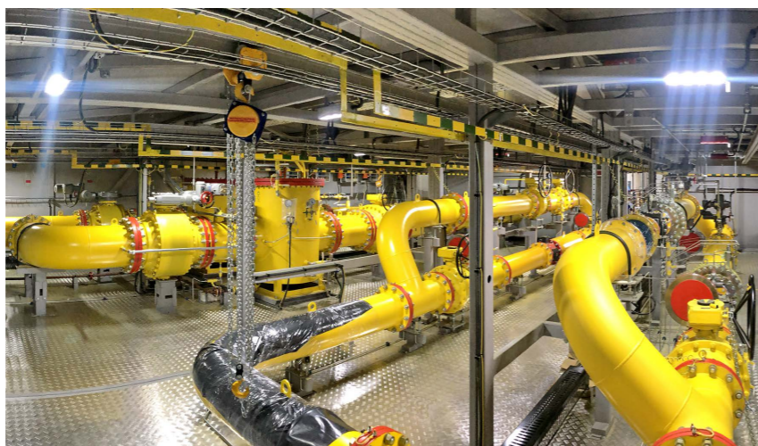
ФОТО 7. Технологическое пространство одного из модулей газорегуляторного пункта «ЭНЕРГАЗ»
