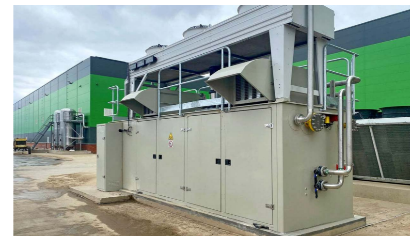
ФОТО 2. Газокомпрессорная станция смонтирована на эксплуатационной площадке нового предприятия
