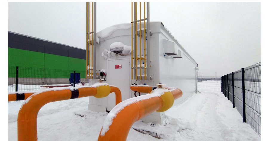
ФОТО 1. Блочный пункт подготовки газа «ЭНЕРГАЗ», действующий на энергоцентре завода НАУАТ
