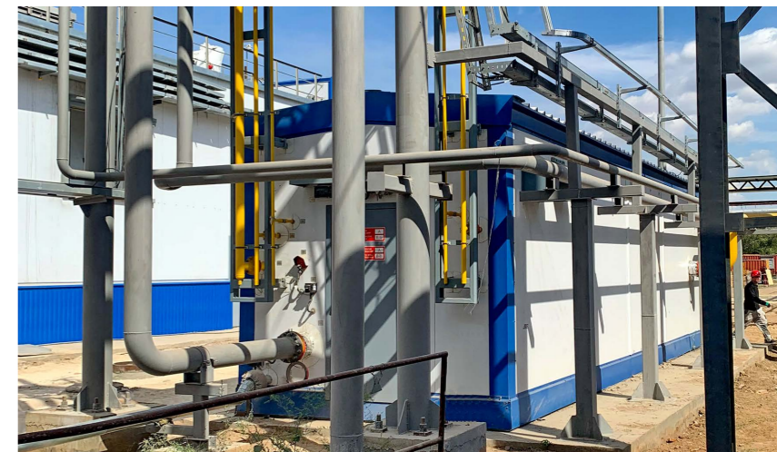
ФОТО 5. БППГ «ЭНЕРГАЗ» обеспечит подготовку топлива для газотурбинной установки Актюбе ТЭЦ
