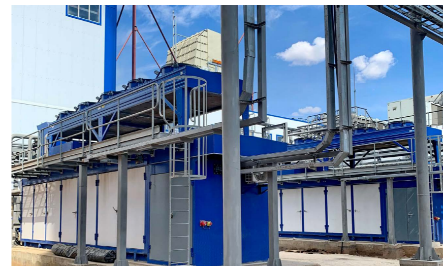
ФОТО 6. Газодожимные установки в составе системы топливоснабжения нового энергоблока
